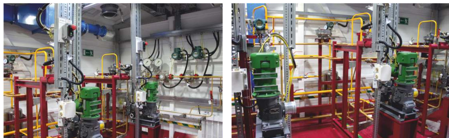
Блок дозирования одоранта для Терминала по хранению и отгрузке смеси пропана-бутана технического (СПБТ) в районе г. Куйбышева ОАО «Томскгазпром»
