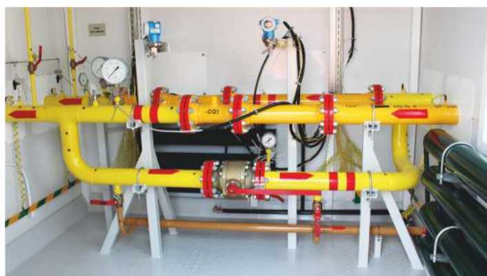
Блок учета газа Усть-Харампурского месторождения ООО «РН-Пурнефтегаз»
