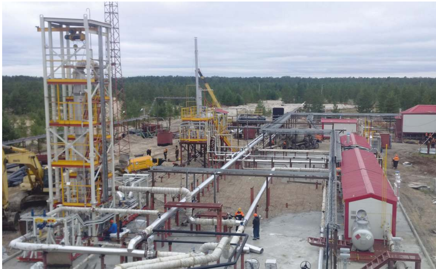
Установка осушки газа и регенерации триэтиленгликоля пос. Нижнесортымский ОАО «Сургутнефтегаз»
