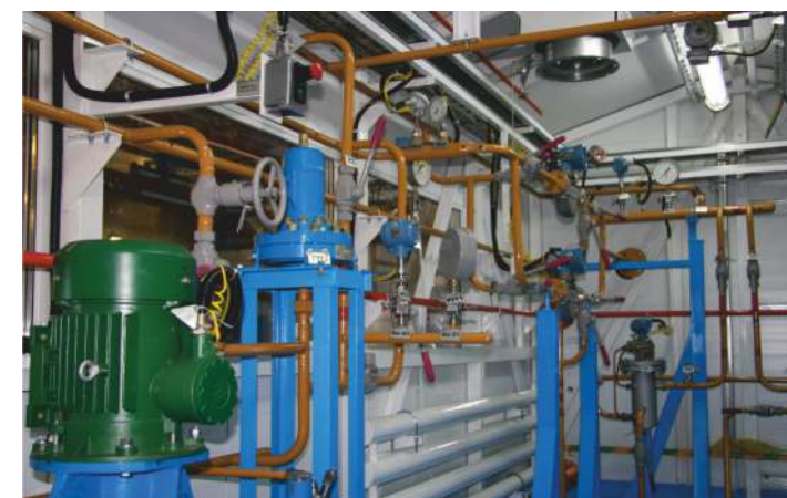
Насосная широкой фракции легких углеводородов для газокomppressorной станции Северо-Останинского нефтяного месторождения ОАО «Томскгазпром»
