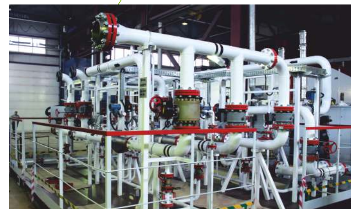
Модульная СИКНС НГДУ «Сургутнефть». ОАО «Сургутнефтегаз»
