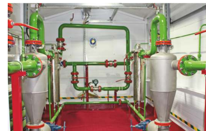
Растворно-солевой узел для Казанского нефтегазоконденсатного месторождения ОАО «Томскгазпром»
