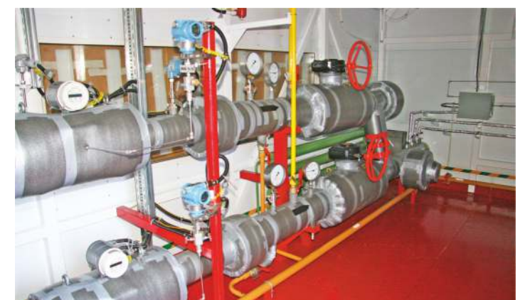
Блок замера газа Казанского месторождения Томской области ОАО «Томскгазпром»
