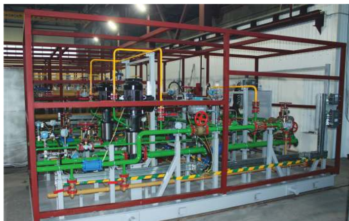
Блок насосов подачи тосола № БН-5. Установка подготовки газа и конденсата Казанского нефтегазоконденсатного месторождения ОАО «Томскгазпром»
