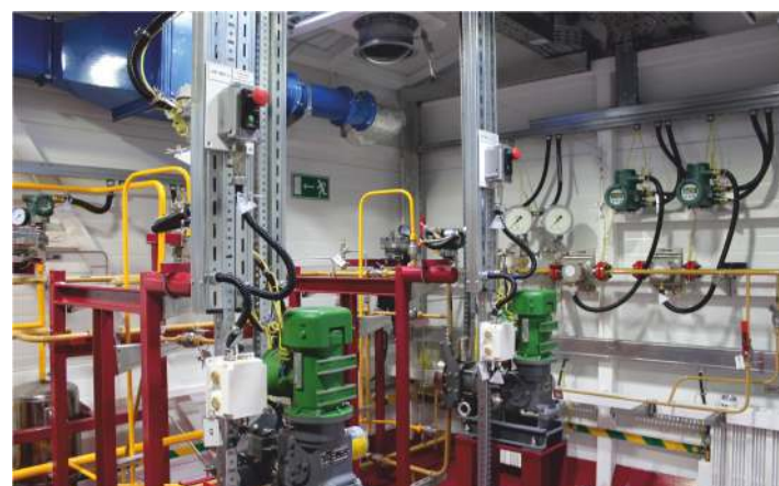
Блок дозирования одоранта для Терминала по хранению и отгрузке смеси пропана-бутана технического (СПБТ) в районе г. Куйбышева ОАО «Томскгазпром»
