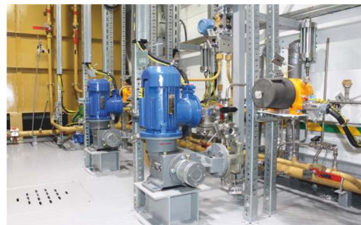
Блок дозирования химреагентов для ООО «Газпромнефть-Развитие», Западно-Мессояхское месторождение. Напорный нефтепровод ПСП-ГНПС №1 трубопроводной системы «Заполярье-НПС «Пур-пе»
