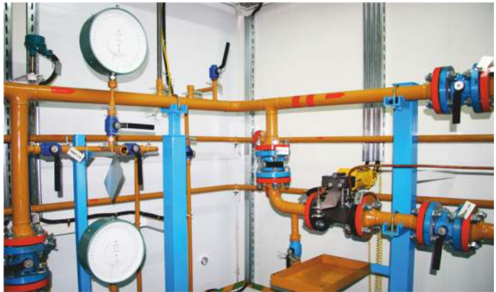
БИК нефти на выходе ПСП «Игол» ОАО «Центрсибнефтепровод»
