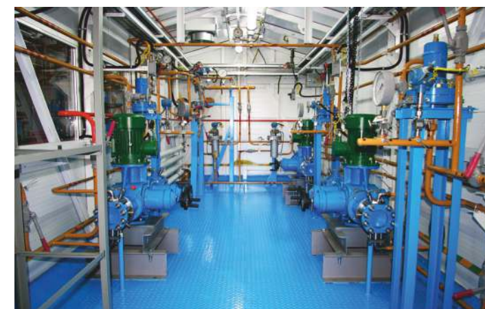
Насосная широкой фракции легких углеводородов для газокomppressorной станции Северо-Останинского нефтяного месторождения ОАО «Томскгазпром»
