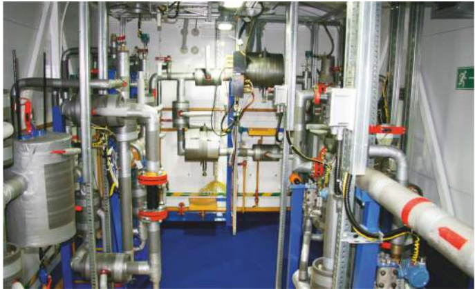
БИК нефти Ярегского месторождения, наливаемой в железнодорожные цистерны на НШУ «Яреганефть» ООО «Лукойл-Коми»
