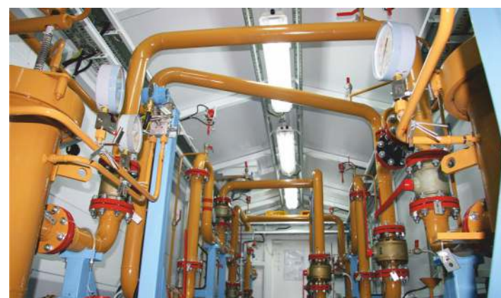
СИКНС Западно-Аянского нефтегазоконденсатного месторождения ООО «ИНК-НефтеГазГеология»
