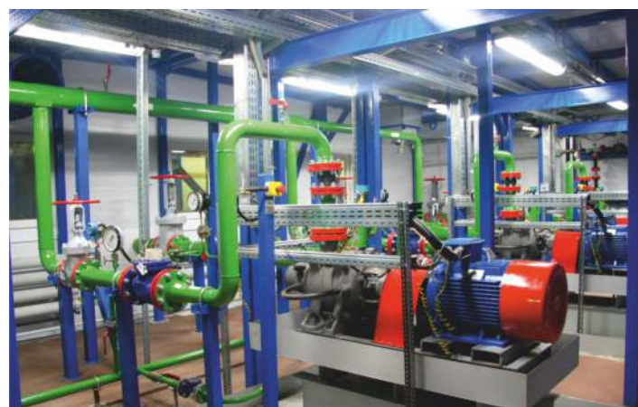
Насосная станция подтоварной воды ДНС-2 Жумажановского месторождения НГДУ «Нижнесортымскнефть» ОАО «Сургутнефтегаз»
