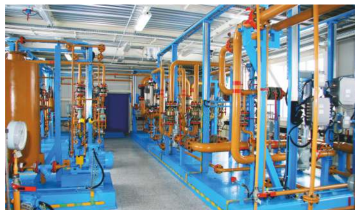
СИКН МНПЗ мощностью 350 тыс. т/год по сырью в с. Семилужки Томской области ООО «Томскнефтепереработка»
