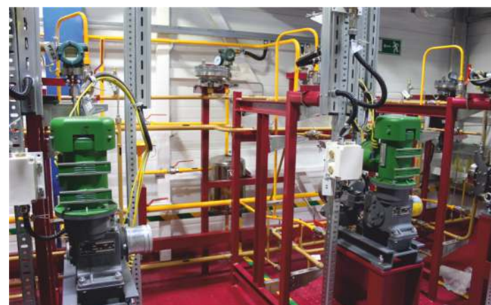
Блок дозирования одоранта для Терминала по хранению и отгрузке смеси пропана-бутана технического (СПБТ) в районе г. Куйбышева ОАО «Томскгазпром»
